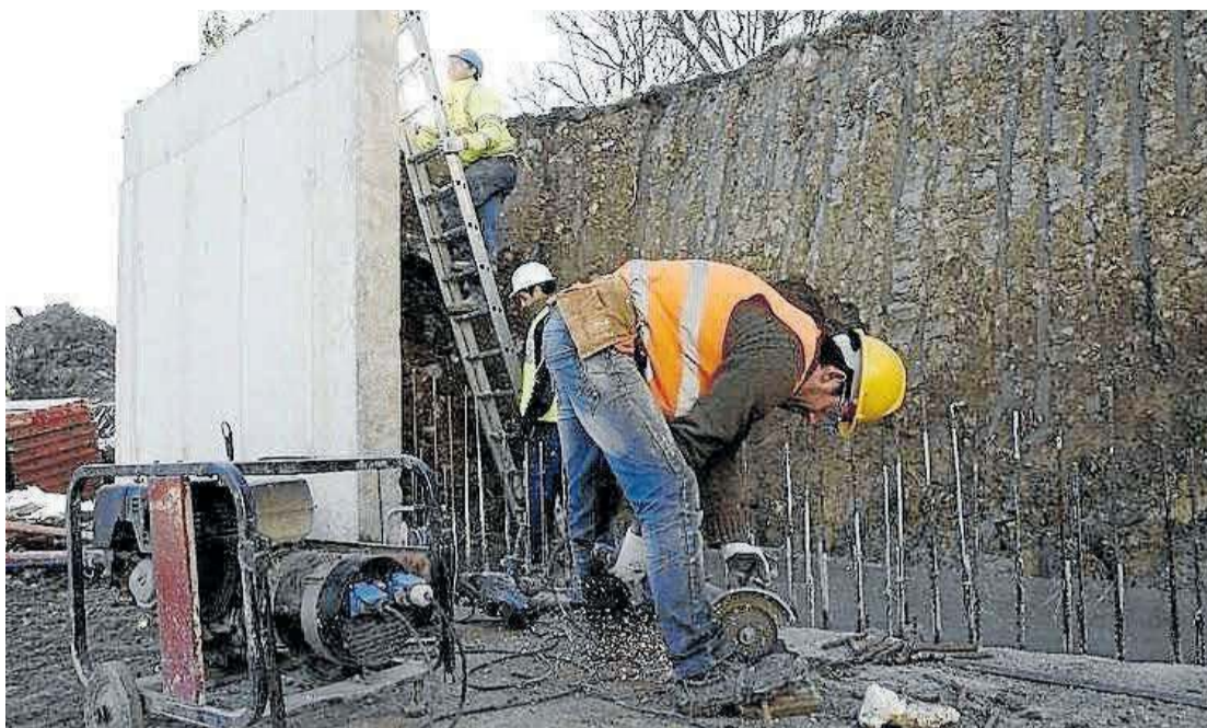
Trabajadores ajenos a esta información, en una obra. Foto: E. P.
